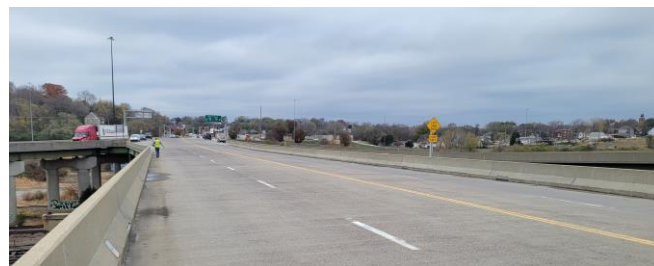
Puente de Central Avenue sobre I-70
